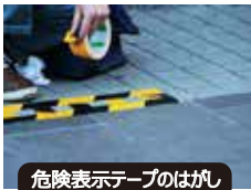
危険表示テープのはがし
